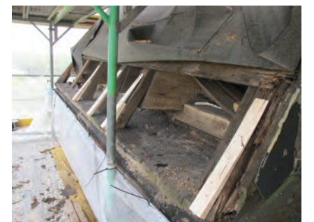
Fotos während der Sanierung
