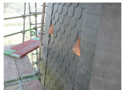
Fotos während der Sanierung
